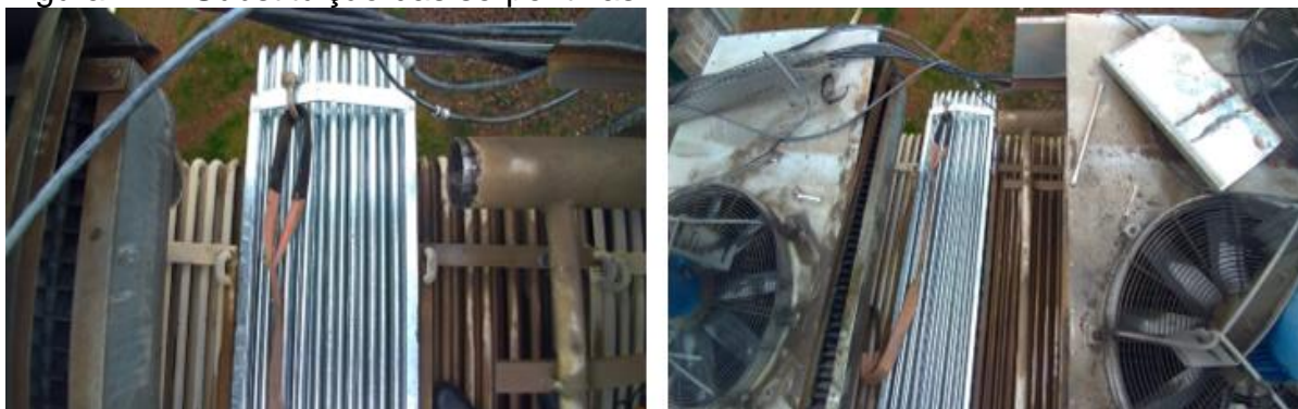
Figura 14 – Substituição das serpentinas
