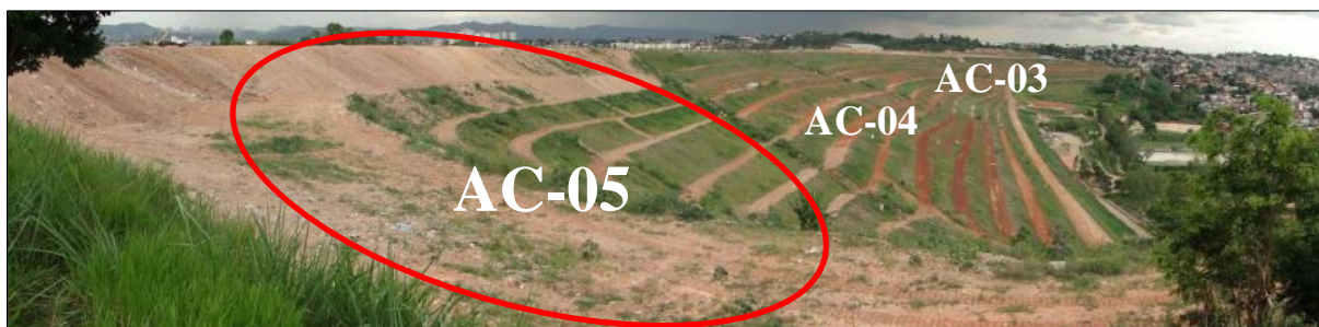
Figura 18 – Visão geral dos taludes das células AC-03, AC-04 e AC-05, em primeiro plano observa-se a célula AC-05.
