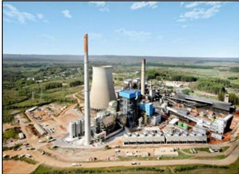
Figura 11 – Vista aérea do complexo Termelétrico de Candiota - RS
