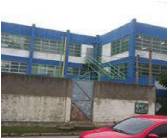
a) Foto da fachada da frente da escola
