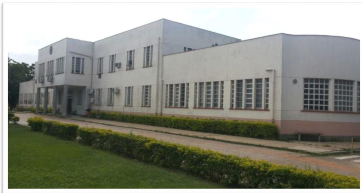
FIGURA 1 - Fotografia da fachada do Hospital de Clínicas Veterinárias da Universidade Federal do Rio Grande do Sul, Porto Alegre-RS. Fonte: Arquivo pessoal.
