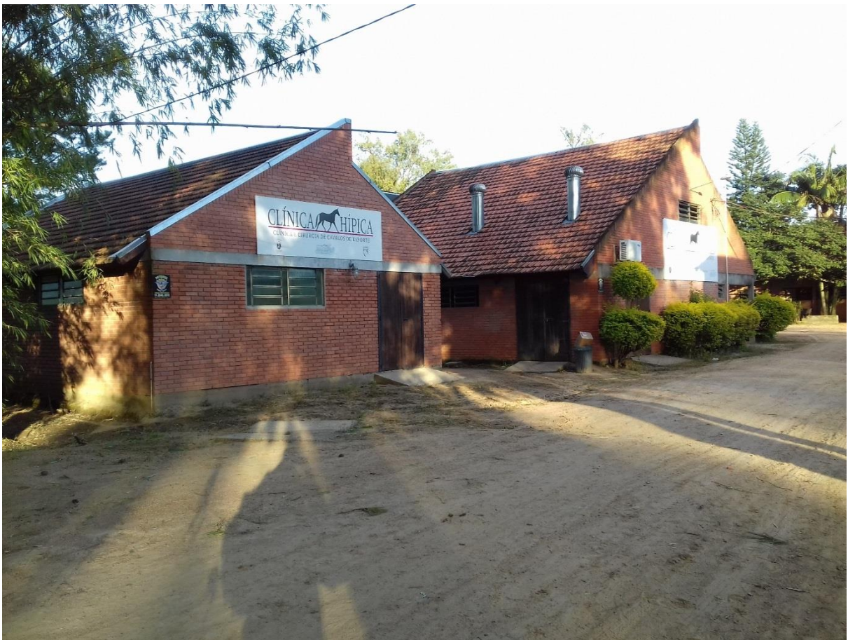
FIGURA 6- Fachada do hospital Clínica hípica em Porto Alegre/RS. Fonte: arquivo pessoal
