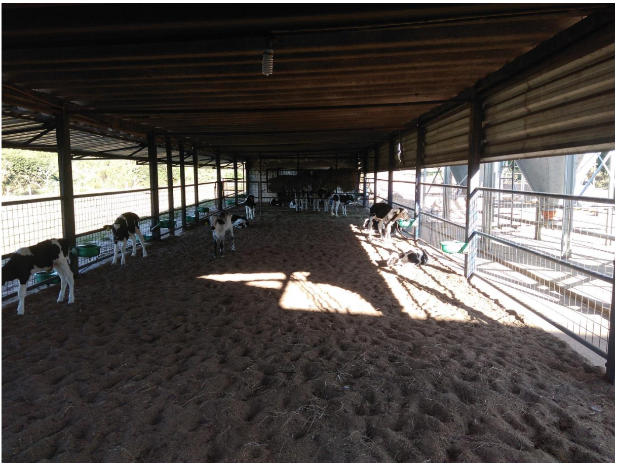
FIGURA 3- Galpão de maravalha para bezerros.
