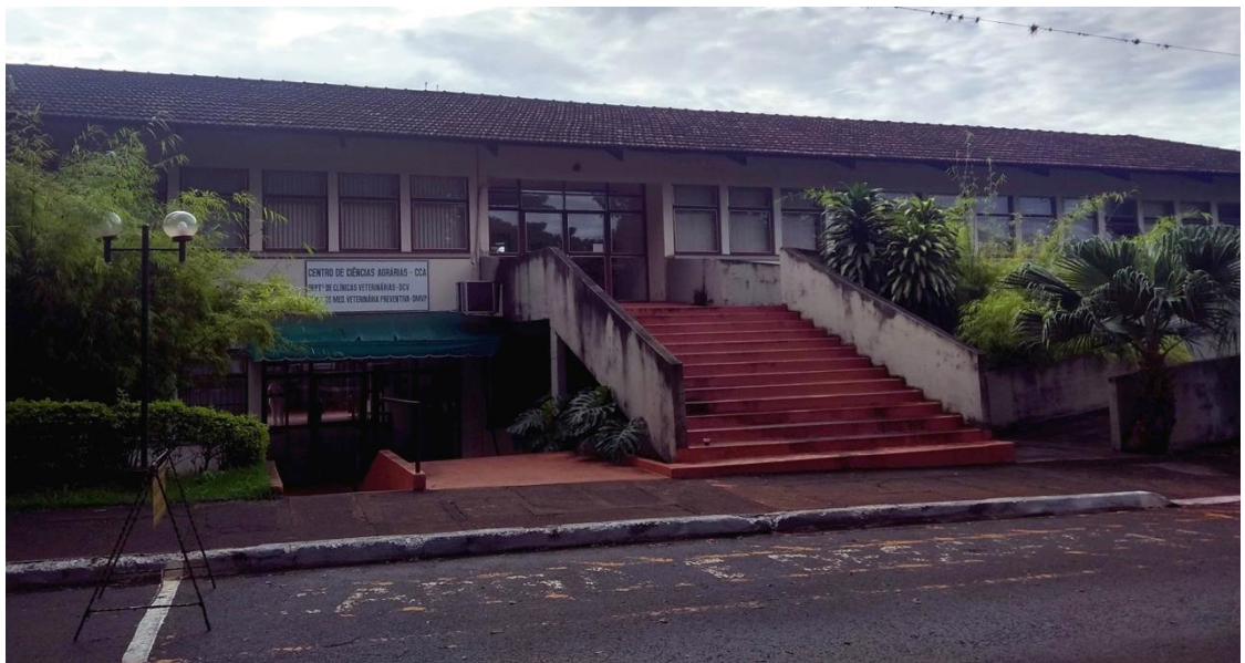
FIGURA 1 - Fachada do Hospital Veterinário da Universidade Estadual de Londrina (UEL). Fonte: Arquivo pessoal.
