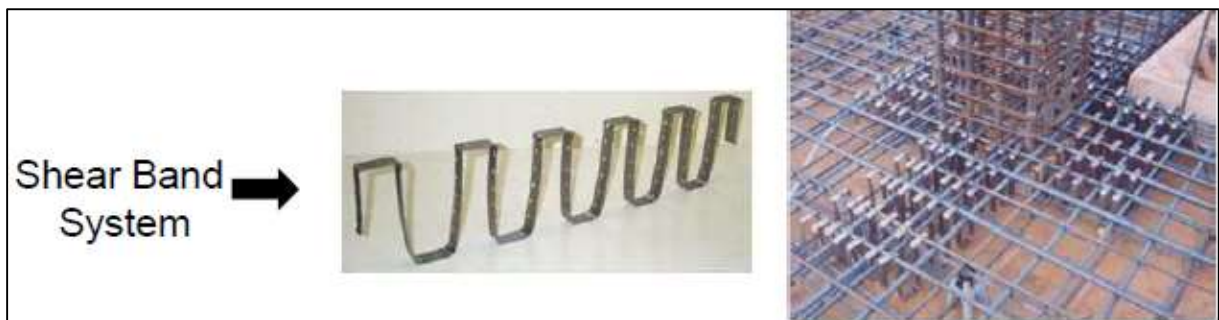
Figura 26 - Shear band system utilizado para armadura de punção
