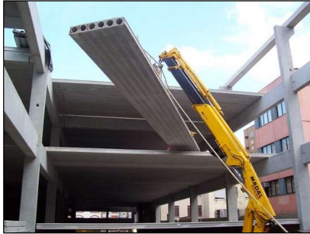
Figura 7 - Sistema de lajes pré-moldadas com painel alveolar
