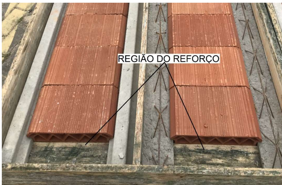
Figura 25 – Posicionamento do reforço na região dos apoios
