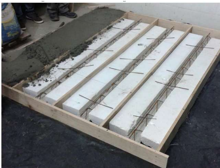
Figura 9 – Execução dos protótipos - Barbieri (2016)
