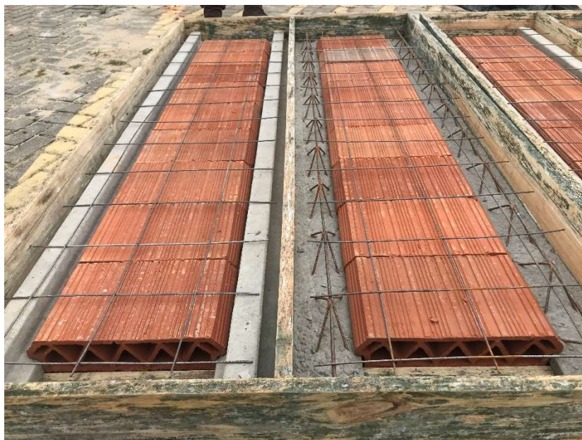
Figura 26 - Pré-laje e armadura de distribuição disposta nas fôrmas.
