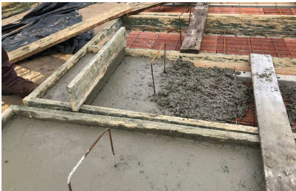
Figura 27 - Concretagem das lajes com ganchos
