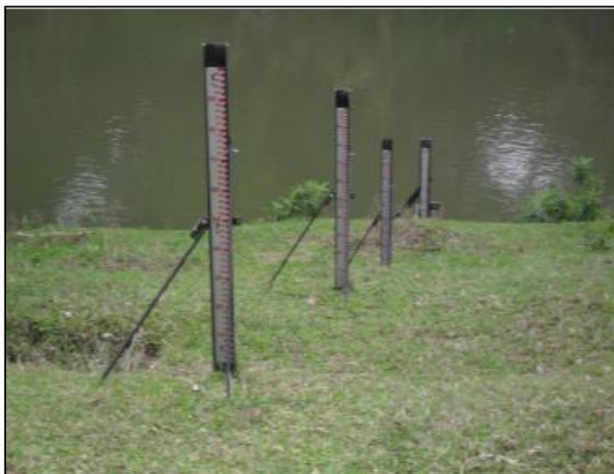
Figura 9– Estação Fluviométrica Convencional
