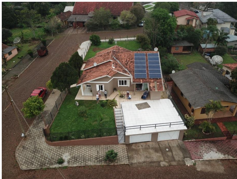
Figura 9 – Instalação sobre cobertura
