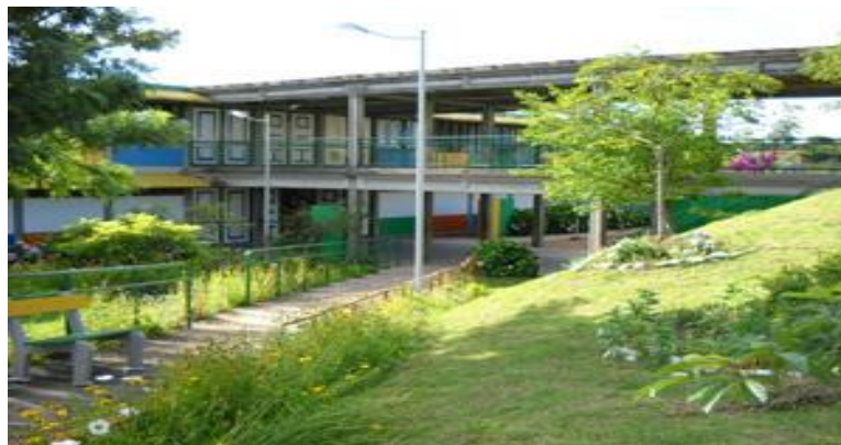
Figura 4 – Vista externa da escola.
