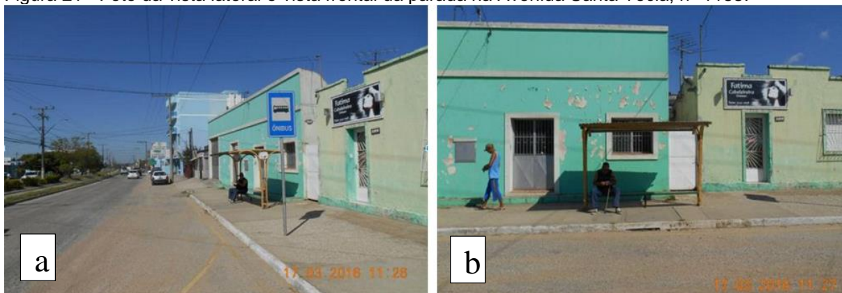
Figura 21 - Foto da vista lateral e vista frontal da parada na Avenida Santa Tecla, nº 1188.
