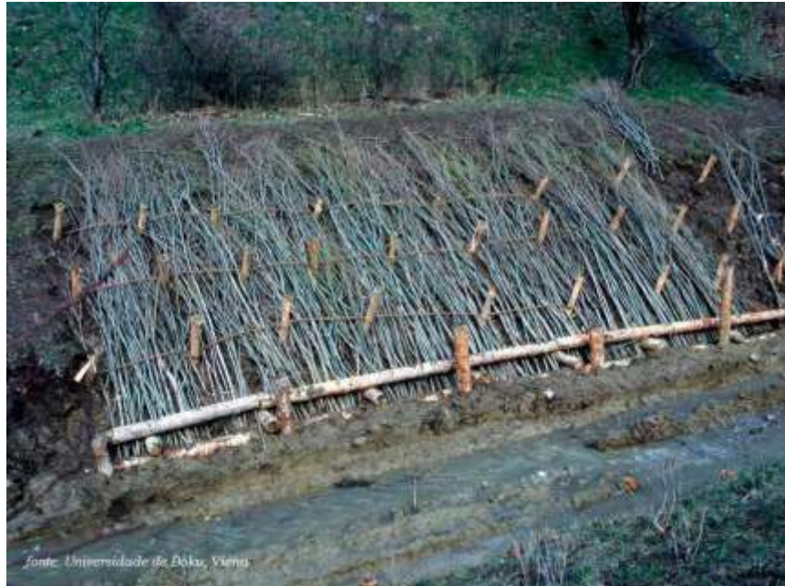
Figura 10: Modelo real aplicado de esteira viva. FONTE: Ecosalix (2016). Disponível em: < http://ecosalix.pt/esteira-viva/ >.
