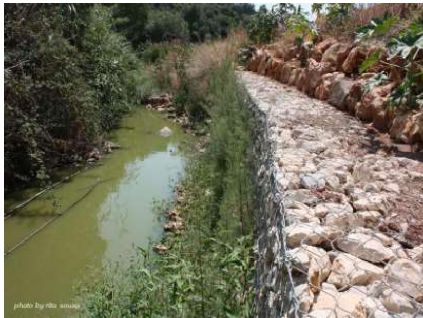
Figura 15: Gabião vivo em defesa longitudinal de talude. FONTE: Ecosalix (2016). Disponível em: < http://ecosalix.pt/gabiao >.
