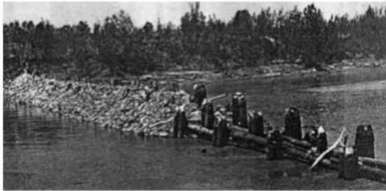
Figura 7: Espigão feito a partir de enrocamento e pilares de madeira, Rio Arkansas. FONTE: Brighetti e Martins (2001).
