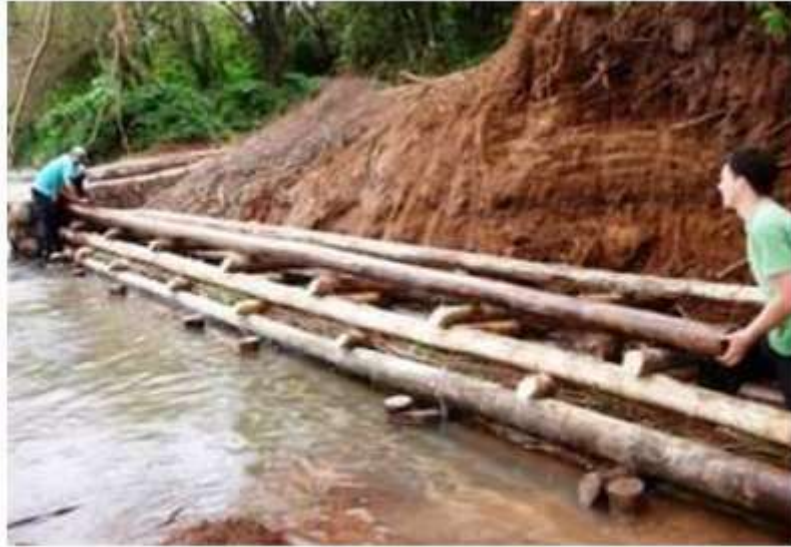
Figura 13: Construção de Parede de Krainer em um talude fluvial. FONTE: Sutili (2007) apud Pinto (2009).
