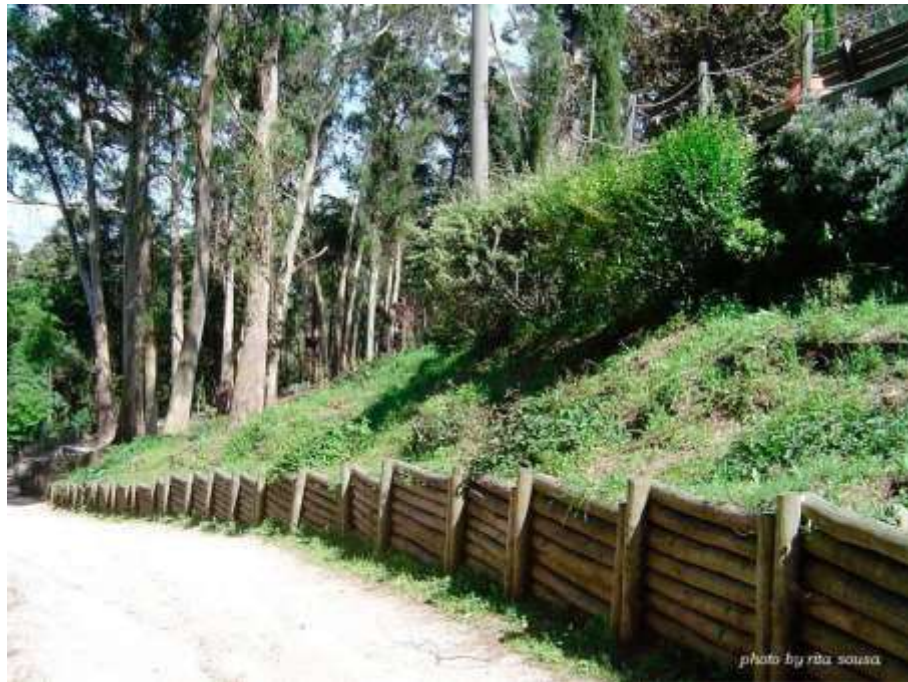
Figura 12: Diques na estabilidade de terrenos íngremes. FONTE: Ecosalix (2016). Disponível em: < http://ecosalix.pt/palica-da-viva >.
