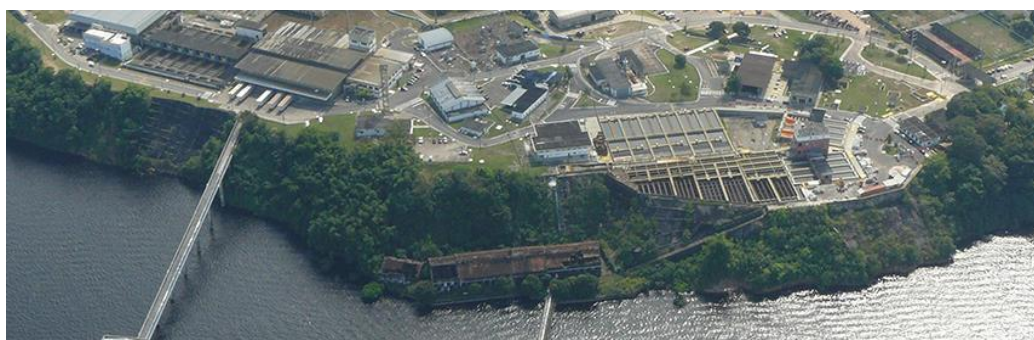
Figura 05: Vista área da empresa Manaus Ambiental, Manaus - Amazônia
