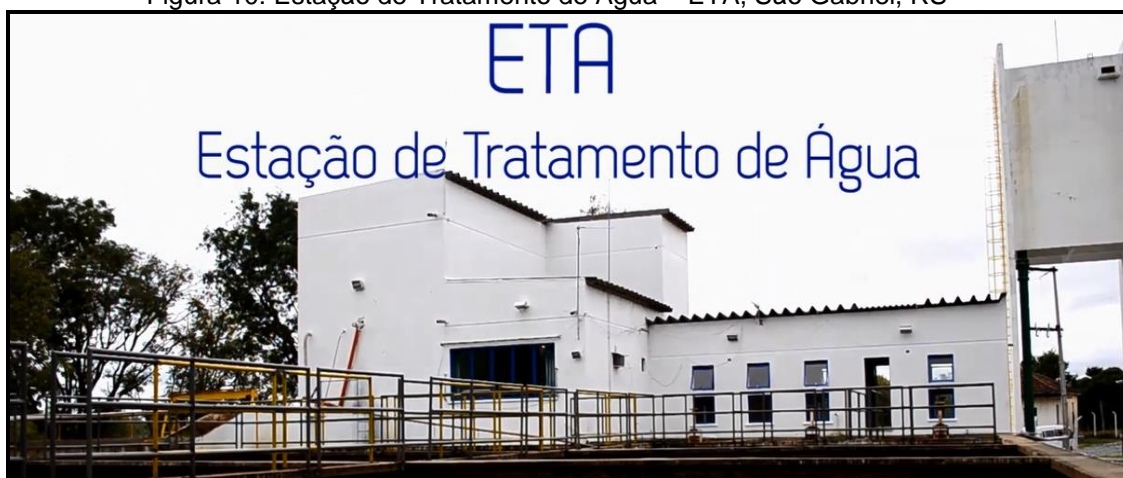
Figura 10: Estação de Tratamento de Água – ETA, São Gabriel, RS
