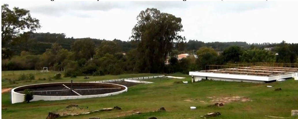
Figura 12: Estação de Tratamento de Esgoto – ETE, São Gabriel, RS
