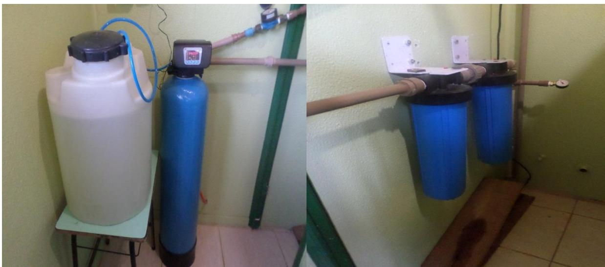
**Figura 8:** Equipamento Abrandador instalado. Fonte: Autora
