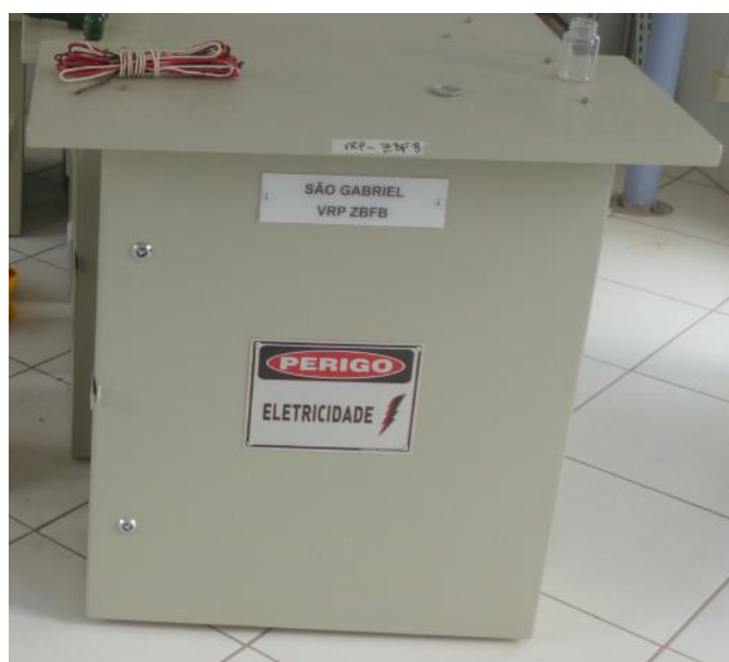
Figura 17: Válvula Reguladora de Pressão
