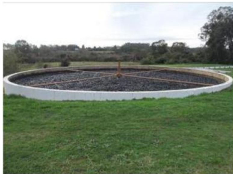
Figura 9: Filtro Percolador: uma das unidades que compõe a ETE Fonte: SGS, 2014.
