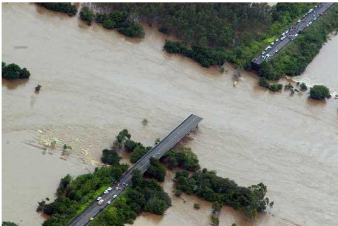
Figura 1 - Queda da ponte sobre o Rio Jacuí em 2010, próximo a localidade de Cerro Chato, Agudo/RS.
