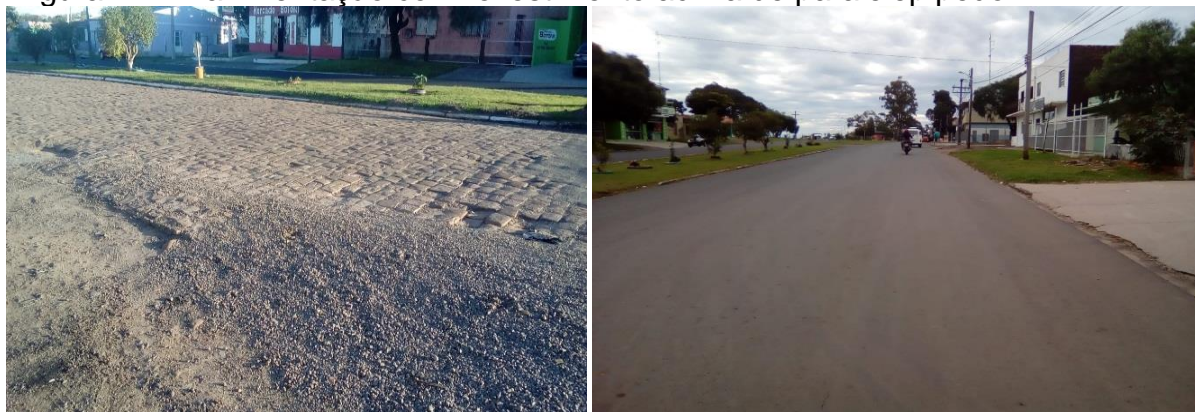
Figura 24 – Pavimentação com revestimento acima de paralelepípedo
