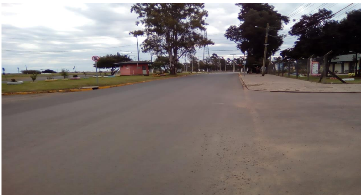
(b) Reconstrução finalizada do trecho entre o ponto 16 e 20
