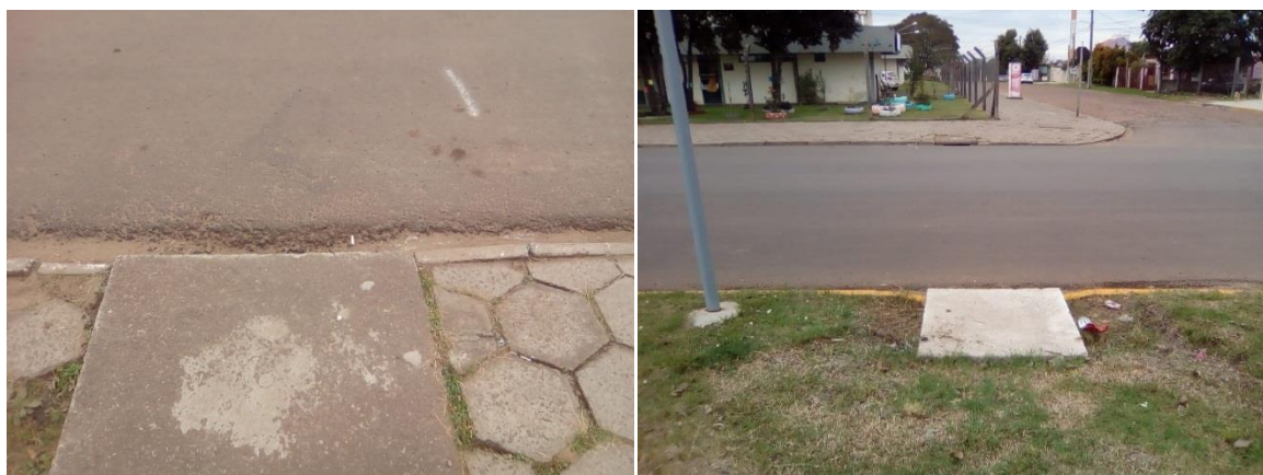
Figura 30 – Tubulação na região de estudo
