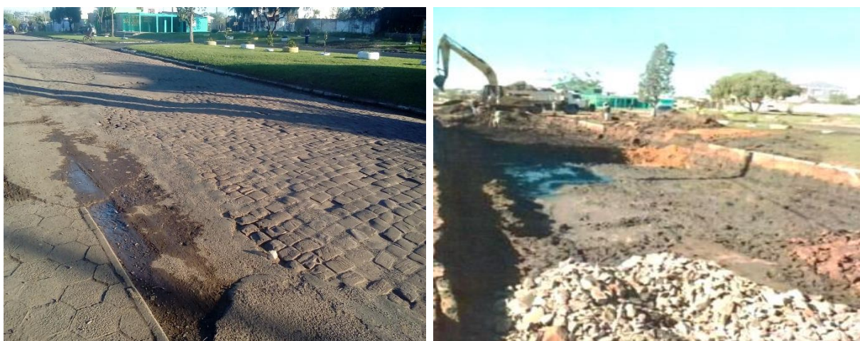
(a) Reconstrução do trecho entre o ponto 16 e 20
