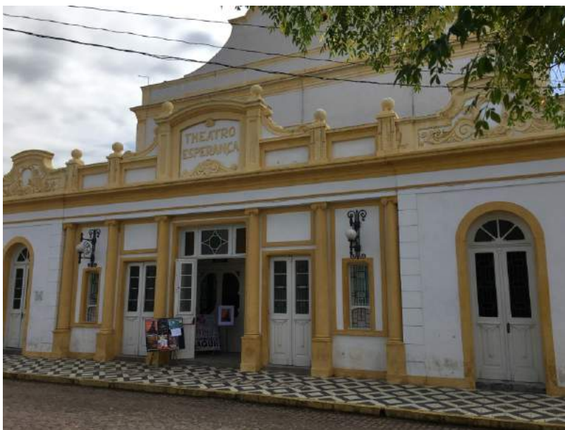
Figura 48 – Fachada restaurada do Teatro Esperança
