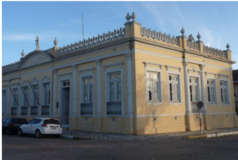
Figura 13 – Residência de Carlos Barboza Gonçalves
