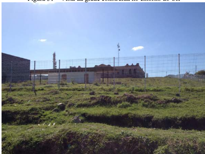
Figura 51 – Vista da grade construída no entorno do CIP
