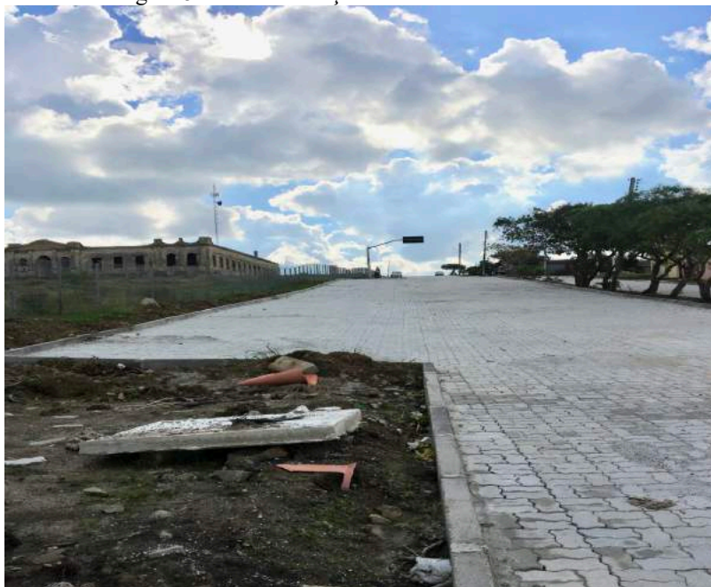
Figura 54 – Pavimentação de rua do entorno do CIP
