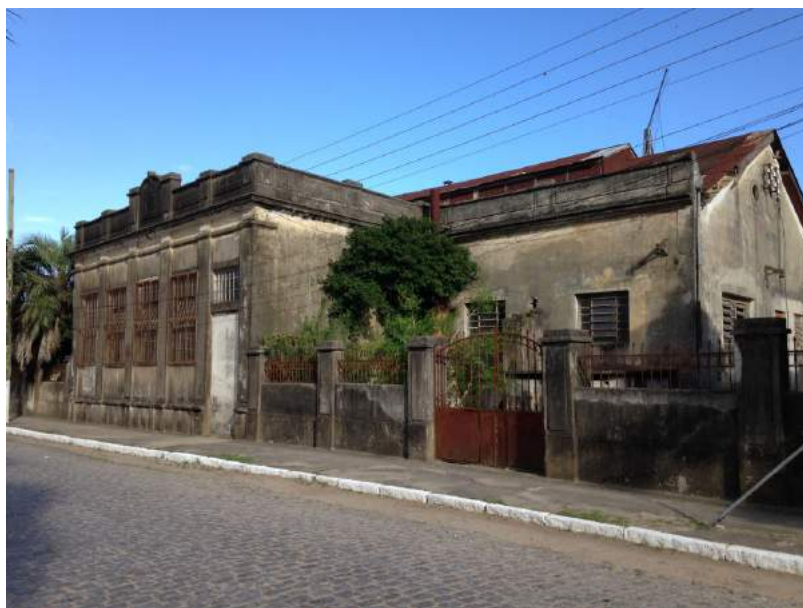
Figura 45 – Antiga Usina de Força de Jaguarão
