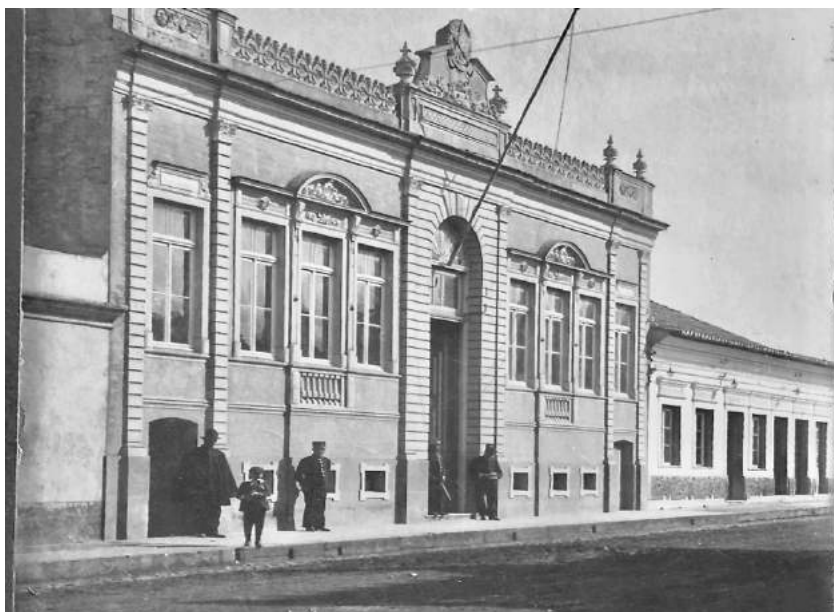
Figura 5 – Prédio da Intendência Municipal de Jaguarão
