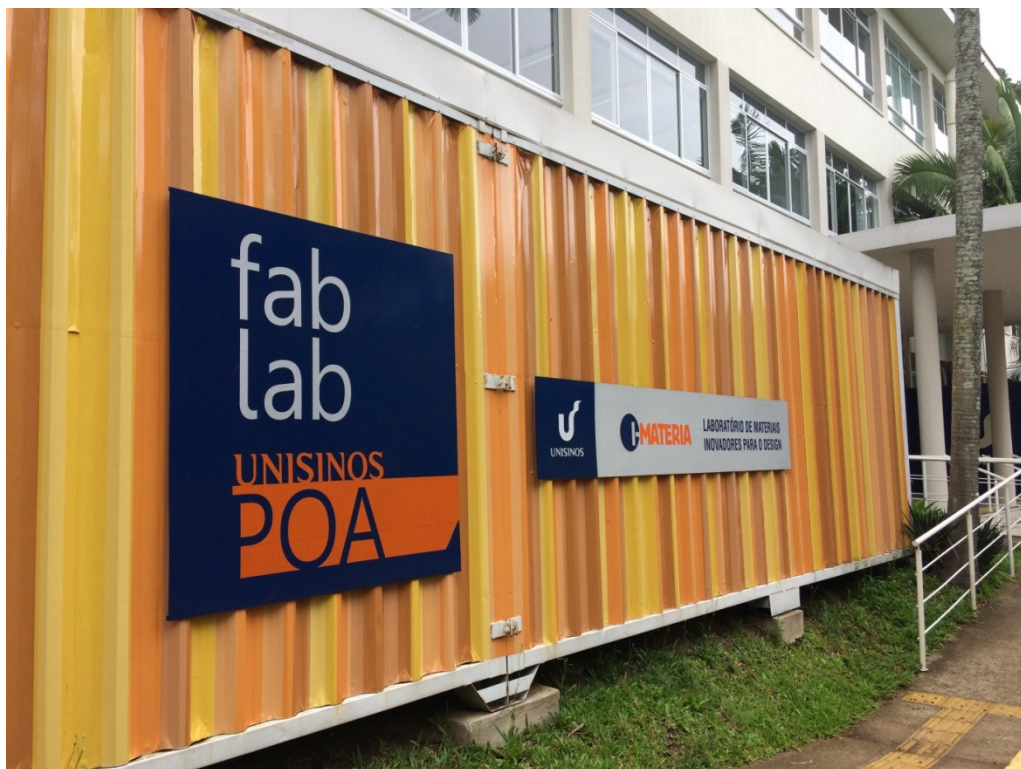
Figura 18 – Fachada principal do Fab Lab Unisinos POA
