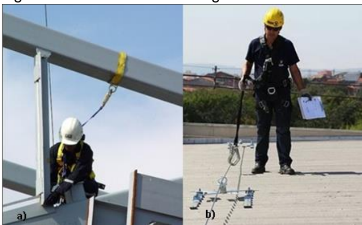
Figura 8 – Sistema de Ancoragem na estrutura
