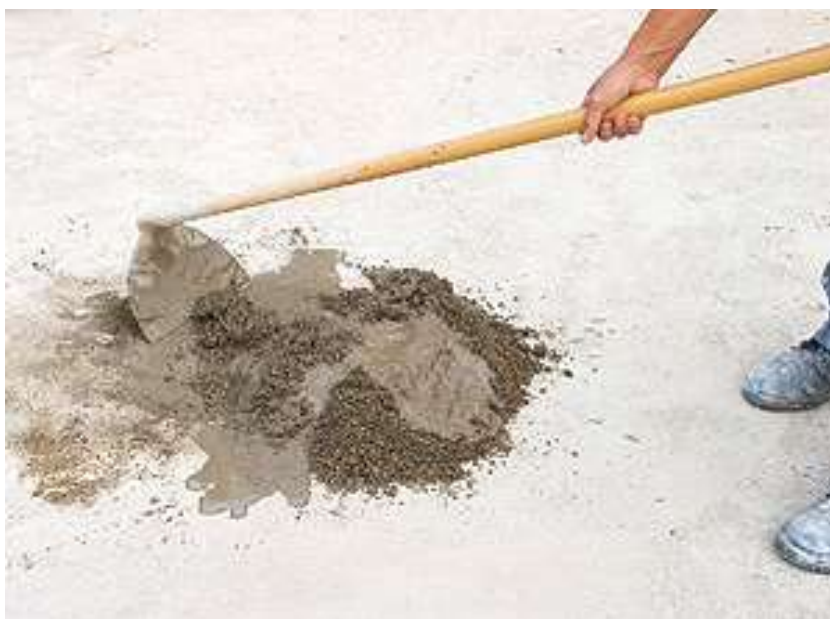
Figura 2 – Argamassa dosada em obra
