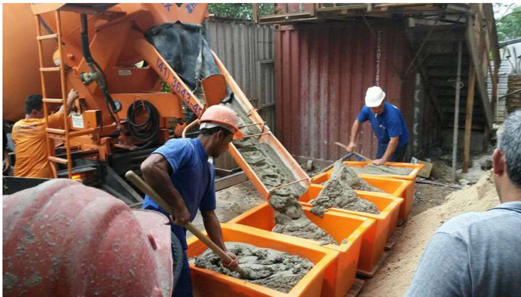
Figura 5 – Argamassa estabilizada sendo entregue na obra
