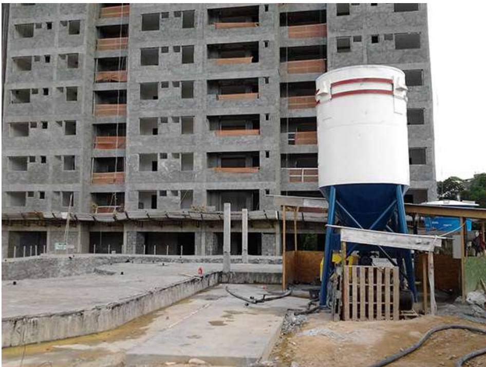
Figura 4 – Argamassa industrializada em silo
