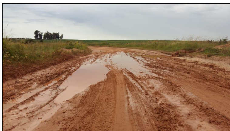
Figura 5 - Drenagem Inadequada
