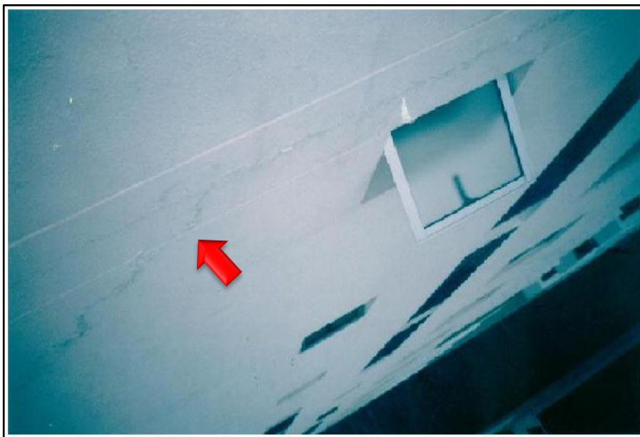
Figura 17 - Trincas
