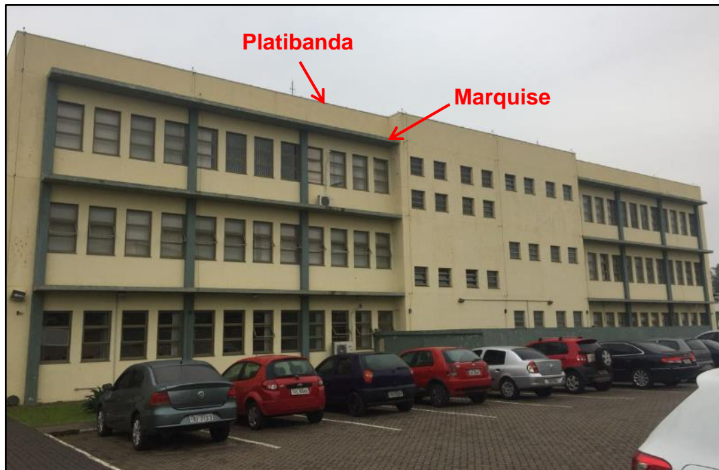
Figura 46 - Fachada Sul Prédio Acadêmico 2
