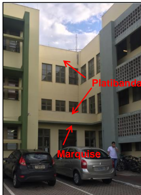
Figura 53 – Prumada 1 do Prédio Administrativo
