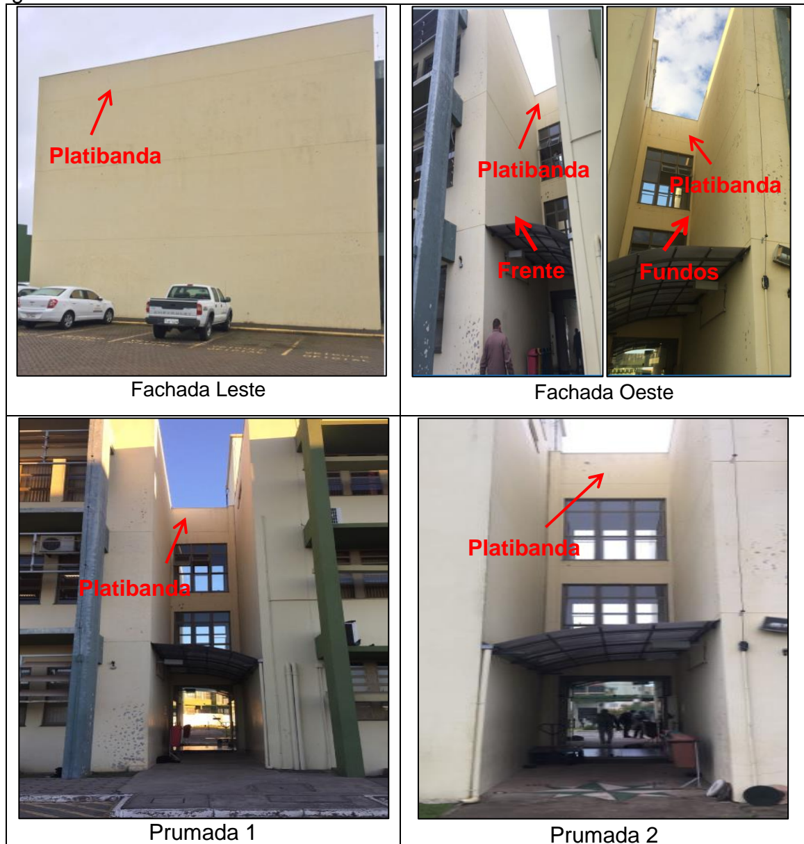
Figura 43- Fachadas Leste e Oeste e Prumadas 1 e 2 do Prédio Acadêmico 2
