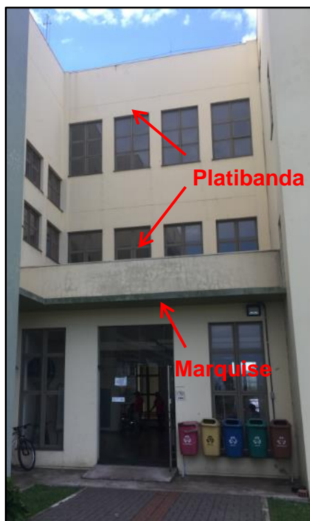
Figura 72 – Prumada 5 do Prédio Administrativo
