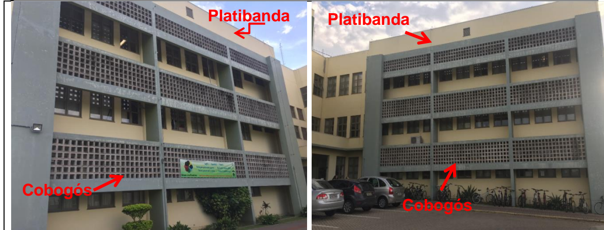
Figura 69 – Fachada Leste do Prédio Administrativo
