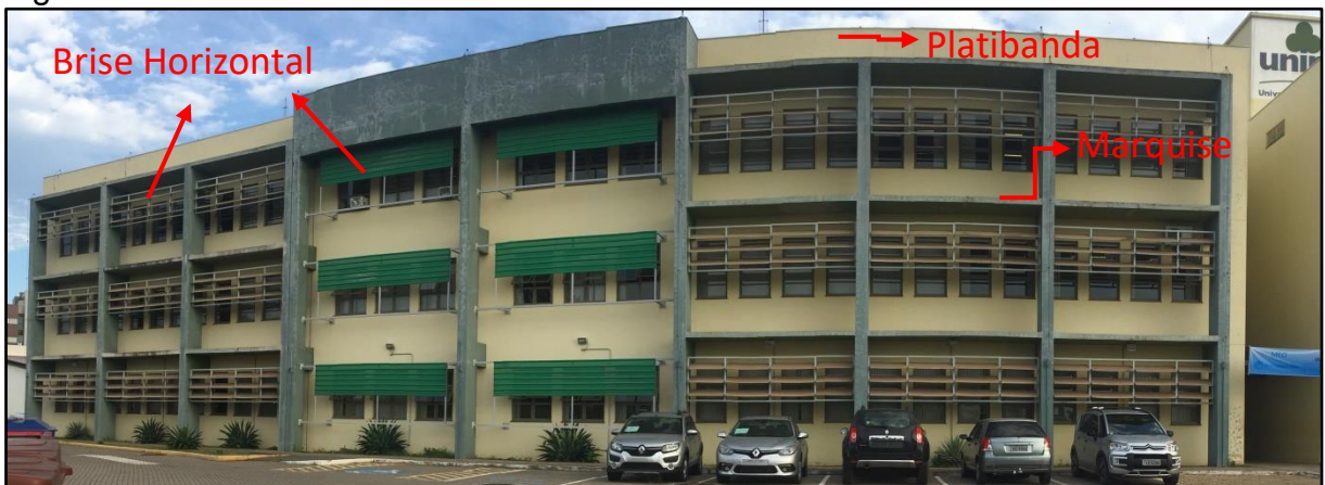
Figura 40 – Fachada Norte Prédio Acadêmico 2
