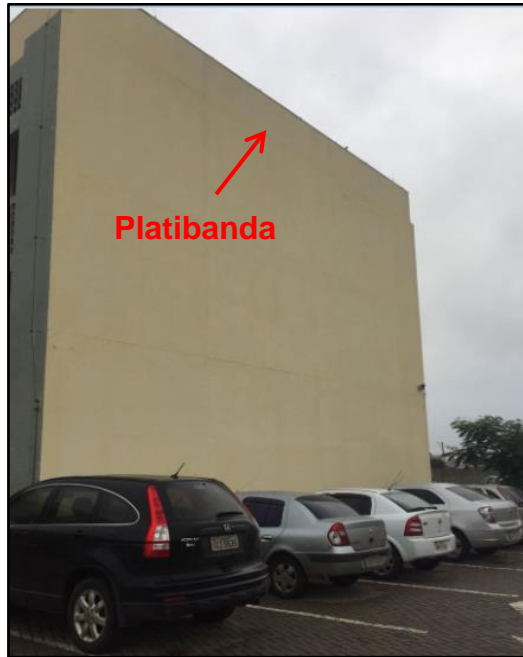
Figura 50 – Fachada Norte do Prédio Administrativo
