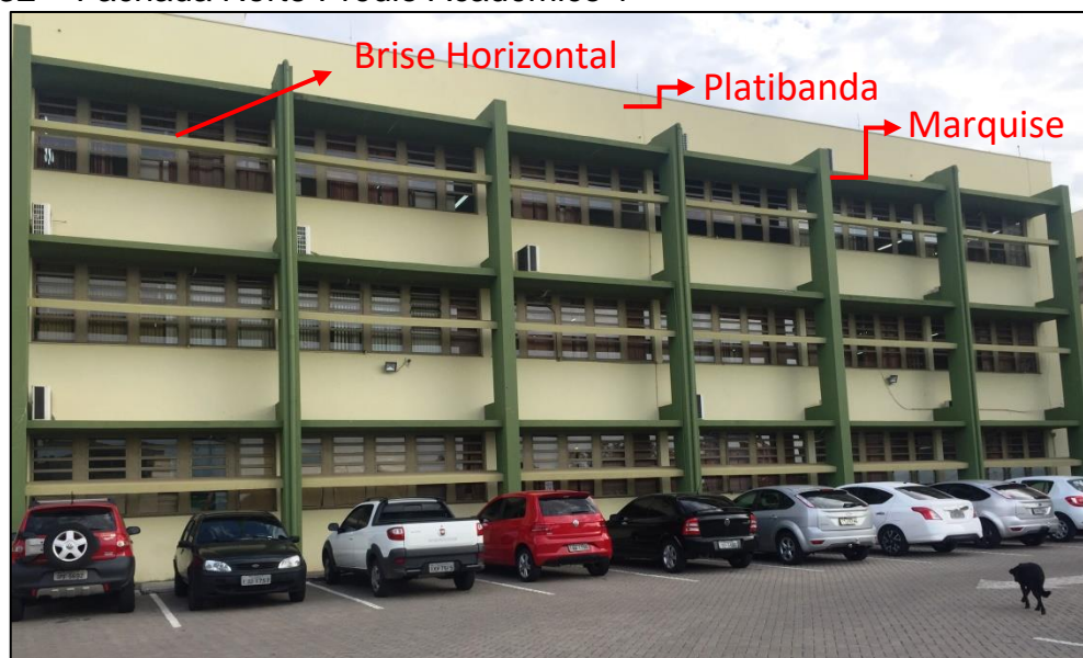
Figura 32 – Fachada Norte Prédio Acadêmico 1
