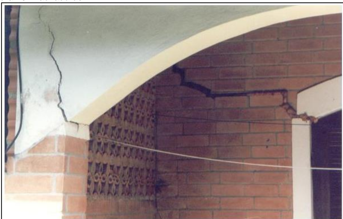
Figura 18- Rachaduras
