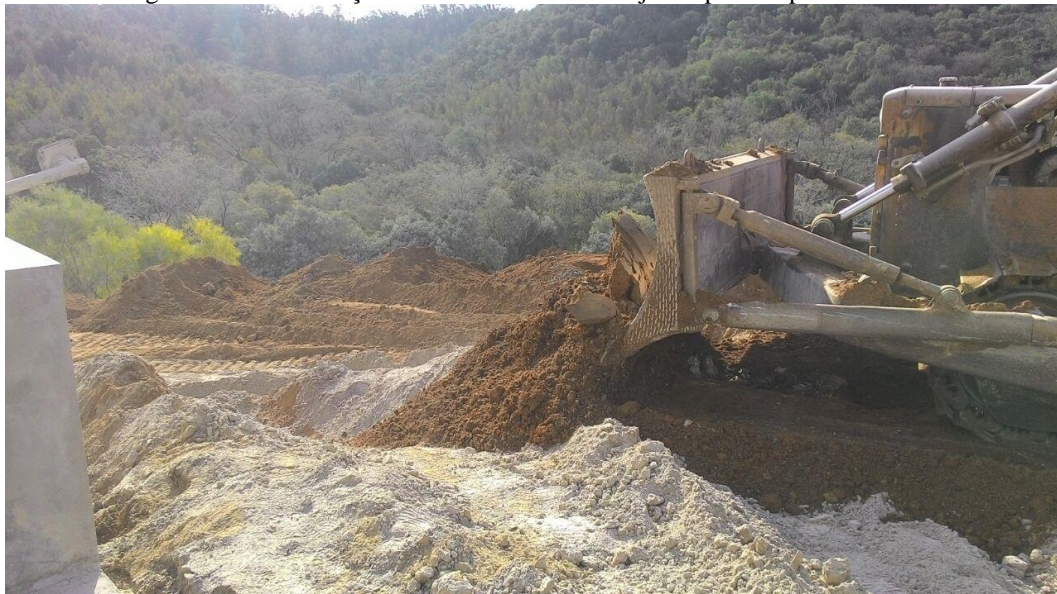
Figura 7: Trator avançando com o material de rejeitos para ampliar o terreno.
