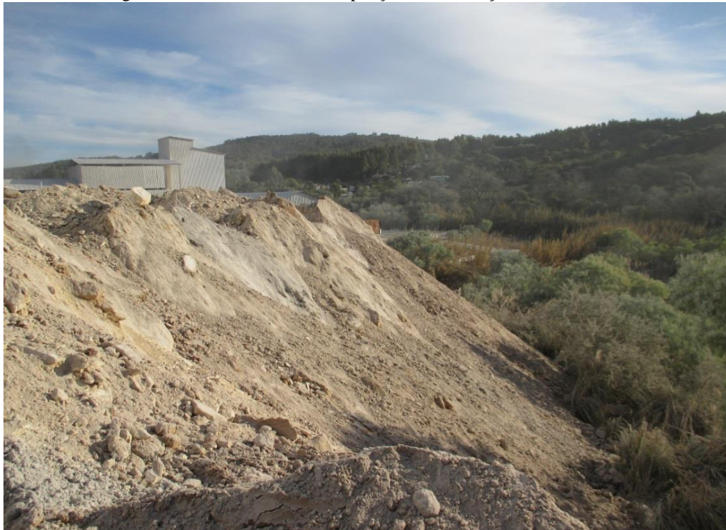
Figura 11: Talude em fase de ampliação e modificação de declividade.
