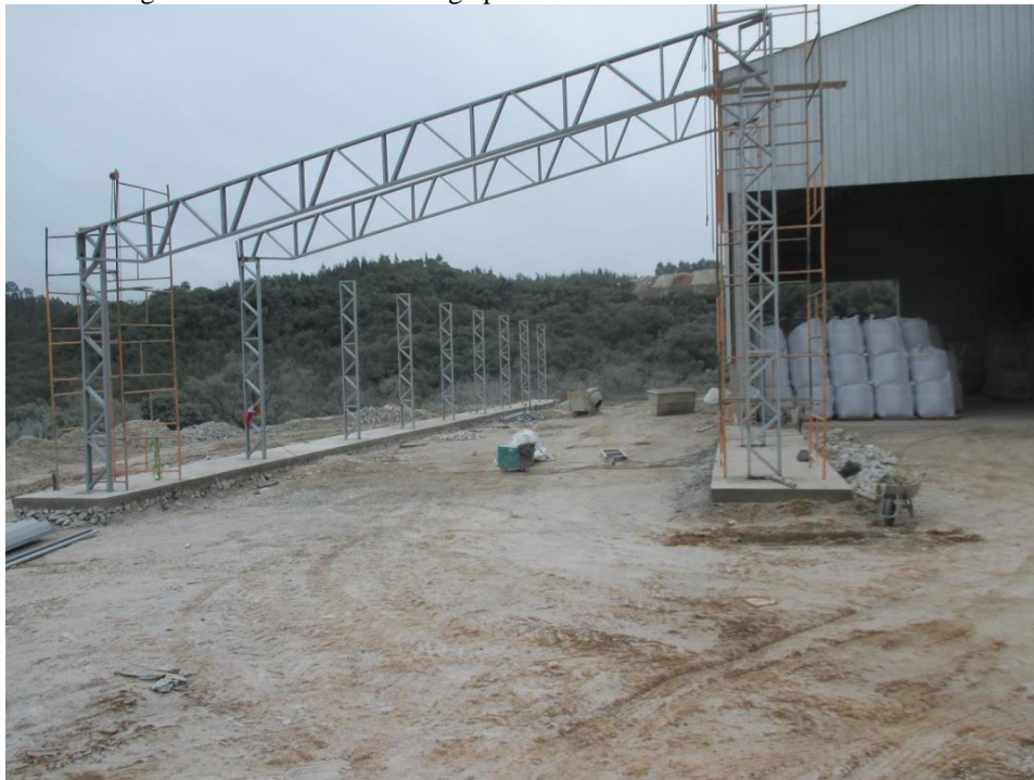
Figura 13: Início de obra do galpão com as estruturas fixadas.
