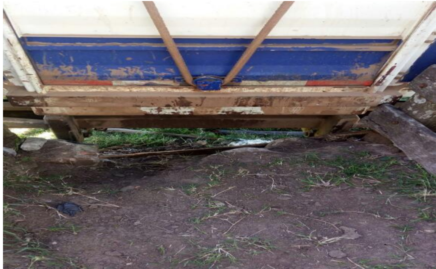
Figura 3 - Embarcador da propriedade em condições precárias.
