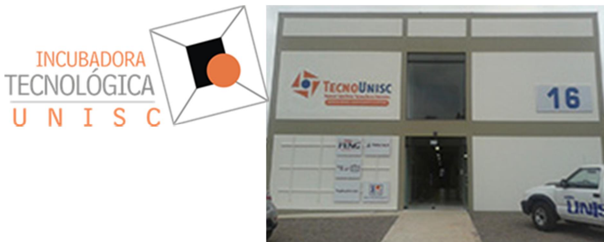
Figura 19 – Identidade visual e fachada do prédio da ITUNISC.
