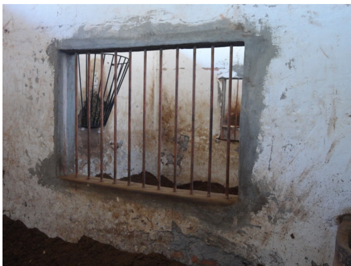
FIGURA 23- Janela maior entre baias.
