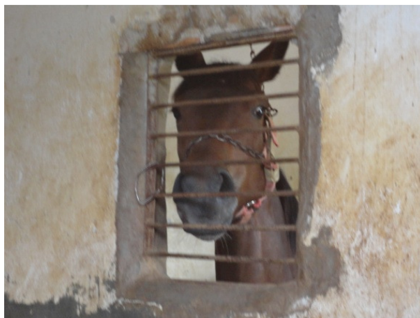
FIGURA 22- Janela pequena entre baias.
