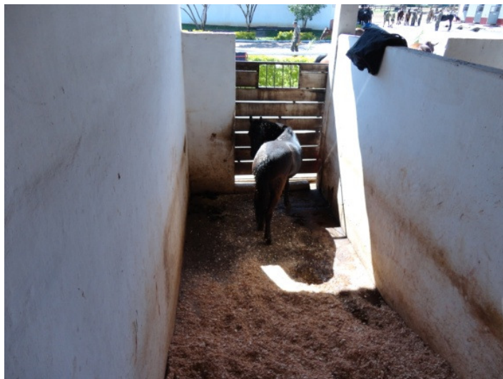
FIGURA 32- Baia com tamanho inadequado.
