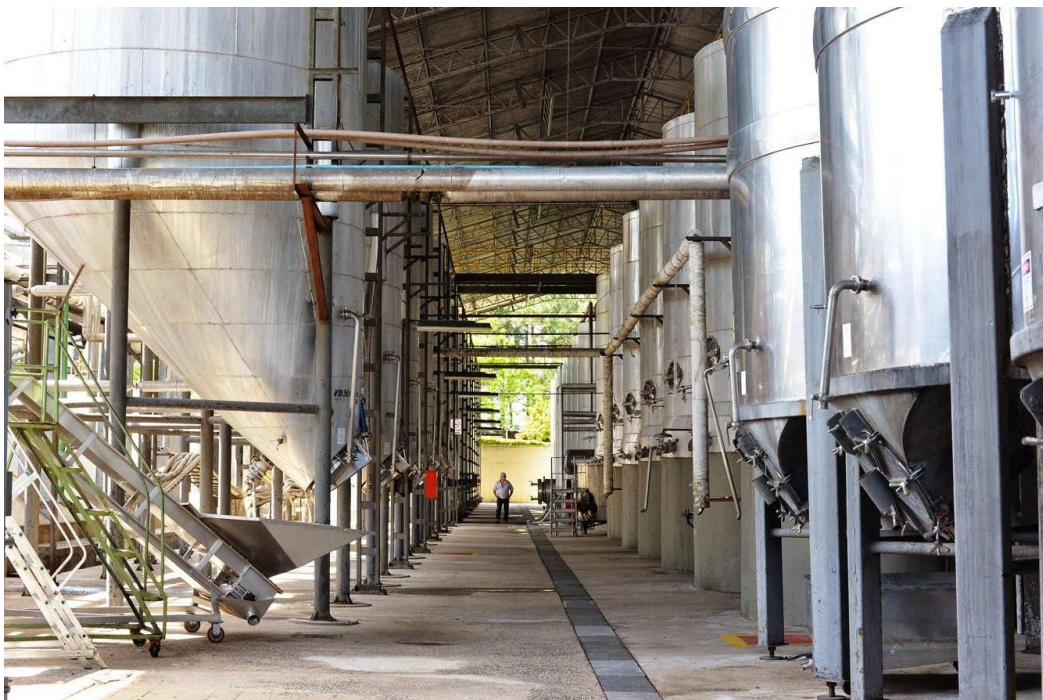
Figura 2 – Vista para os tanques de fermentação.
