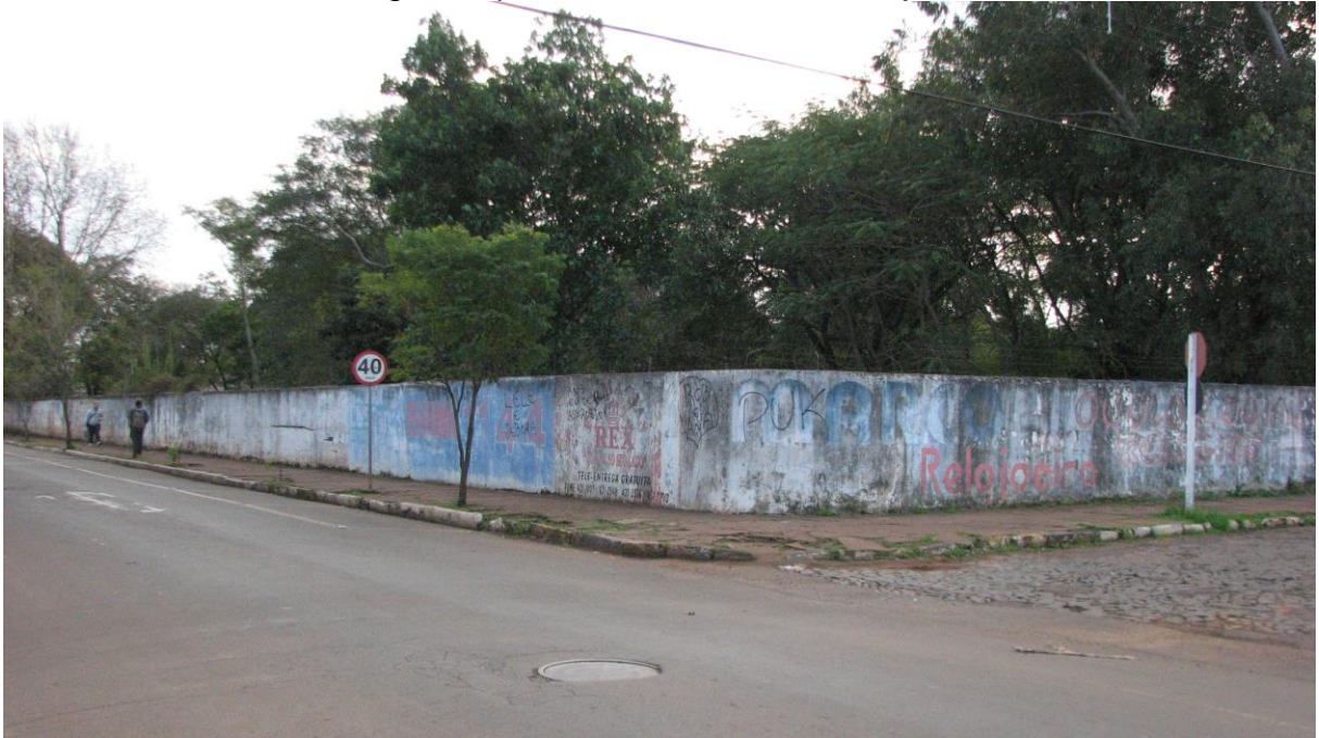
ANEXO 8 – Muro do antigo Hospital São Francisco de Borja antes da reforma
