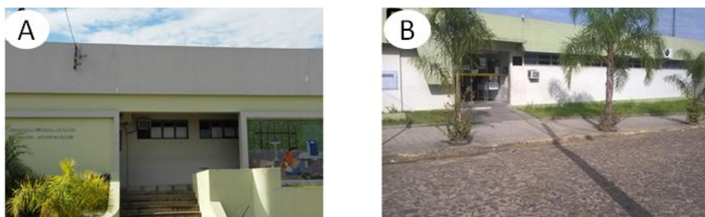
Figura 7 – (A) Prédio da SMSMA do município de Dom Pedrito/RS. (B) Prédio do Posto Central da SMSMA no município de Dom Pedrito/RS.
