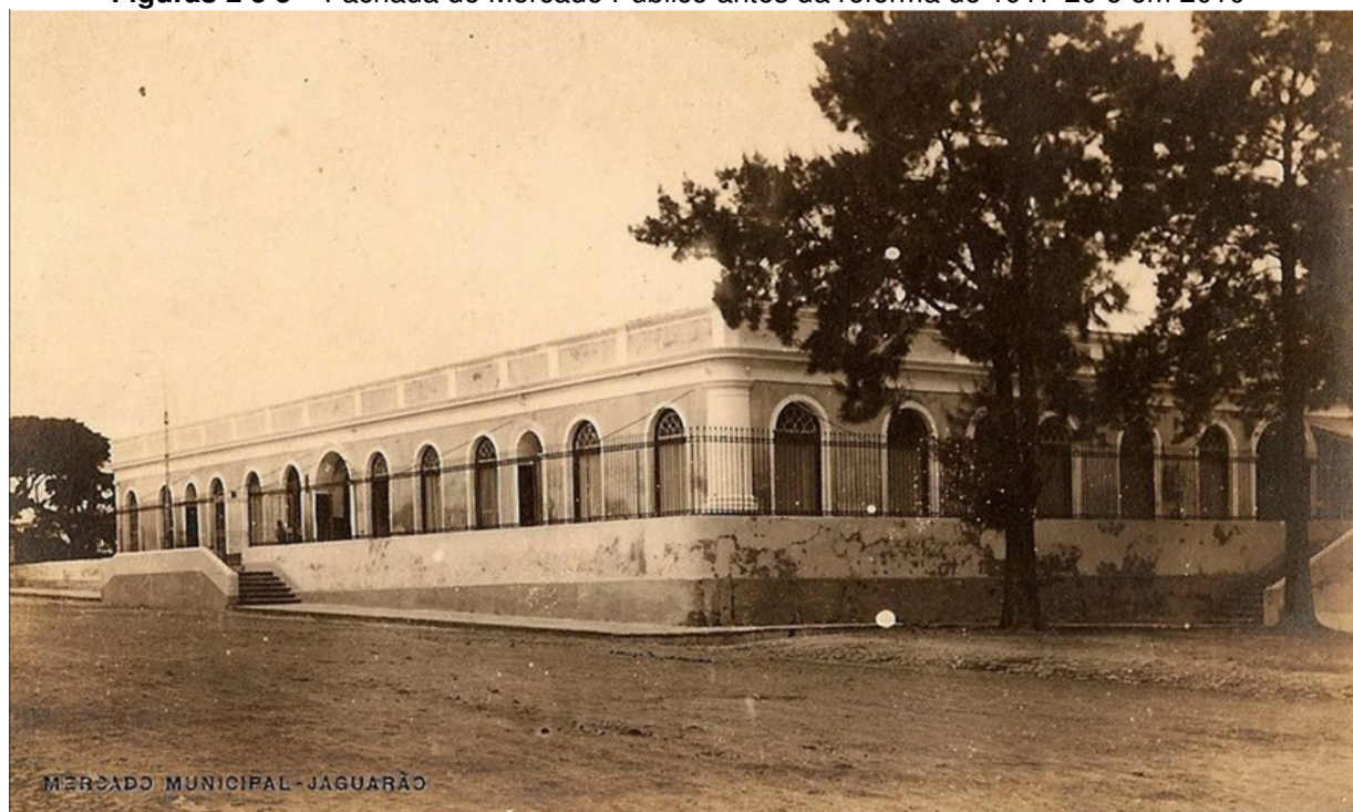
Figuras 2 e 3 – Fachada do Mercado Público antes da reforma de 1917-20 e em 2010
