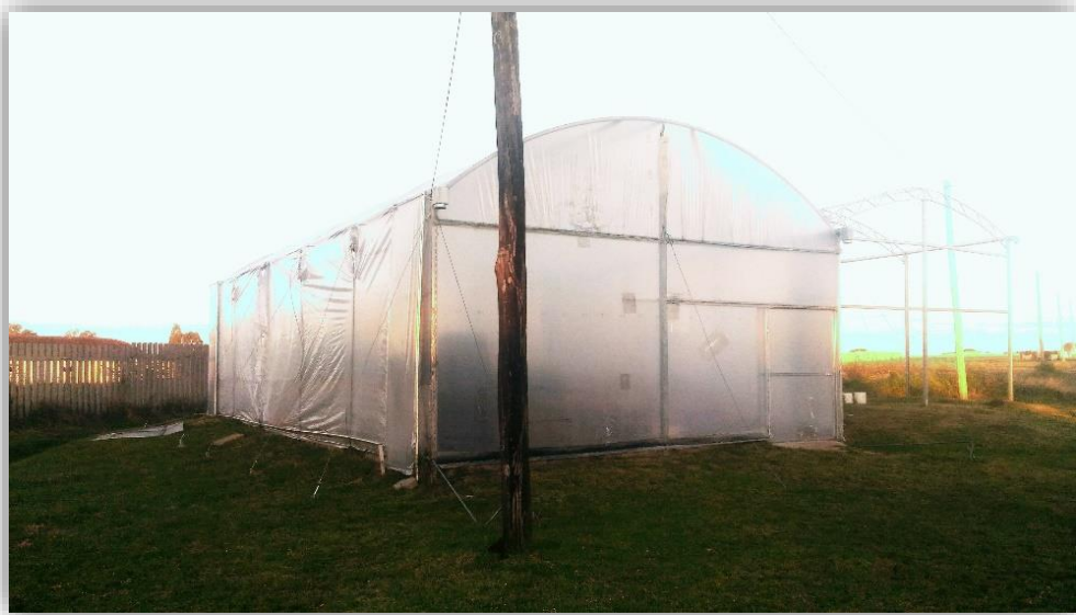
Figura 3 - Casa-de-vegetação da área experimental do curso de Engenharia Agrícola, Unipampa, Alegrete-RS, 2017.
