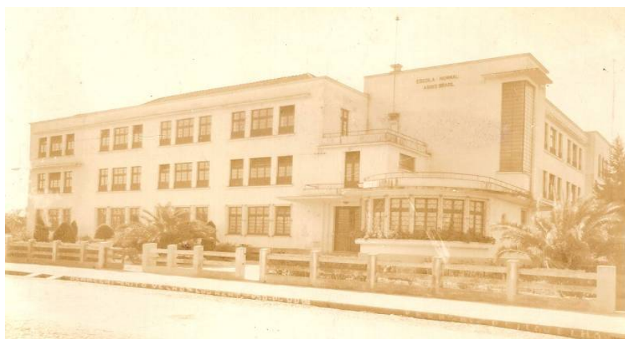
Prédio construído especialmente para a Escola Normal Assis Brasil 1942
