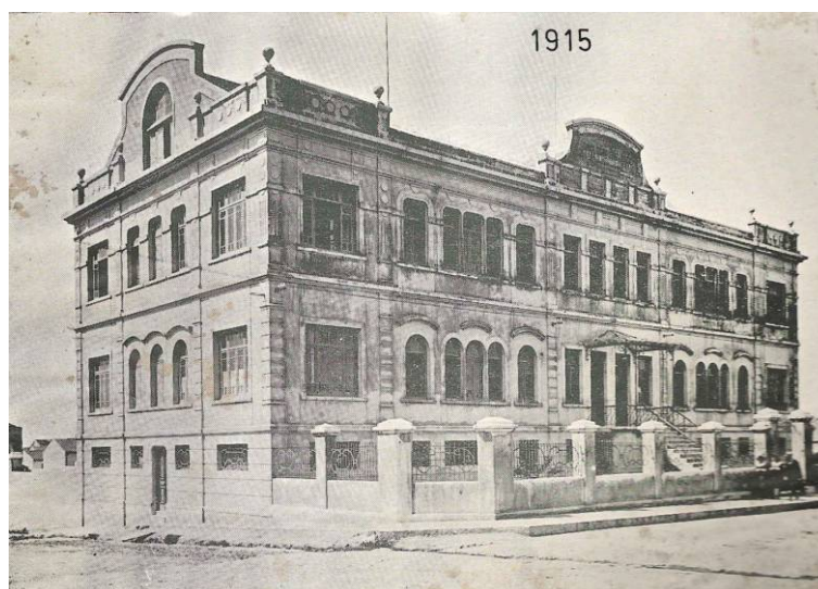
Prédio construído para o Colégio, fotografia de 1915. Fonte: Arquivo particular de Eduardo Arriada.
