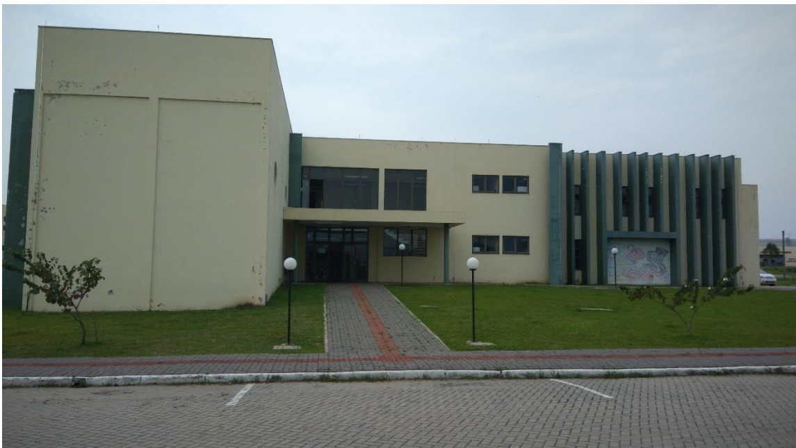
Figura 62-Fachada oeste da edificação do NTIC
