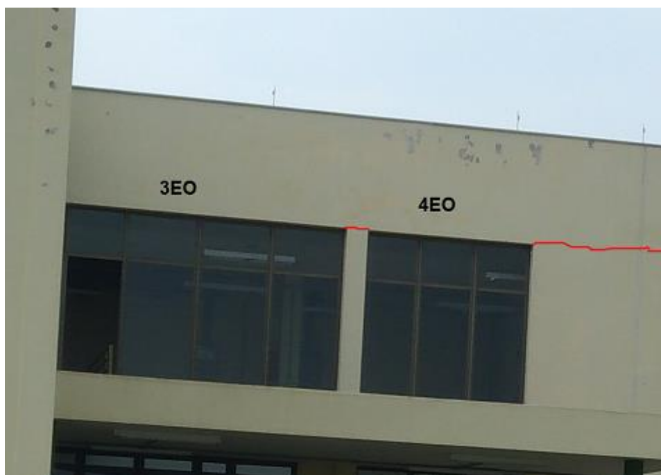
Figura 65-Janelas 3EO e 4EO
