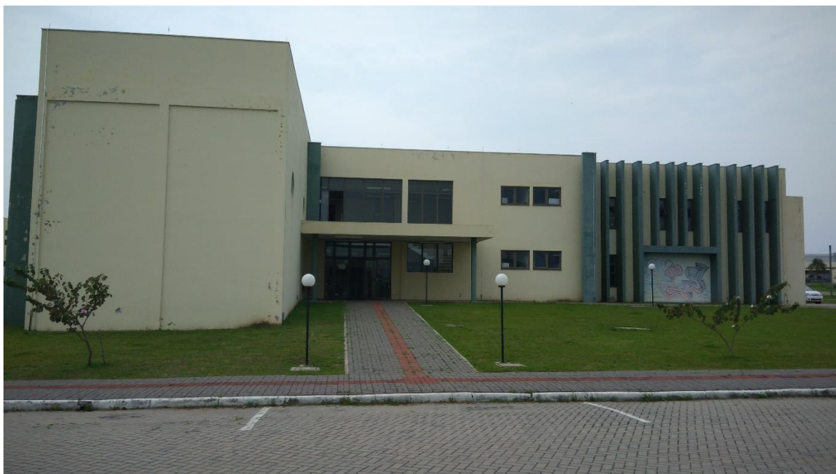
Figura 28-Fachada de acesso a edificação
