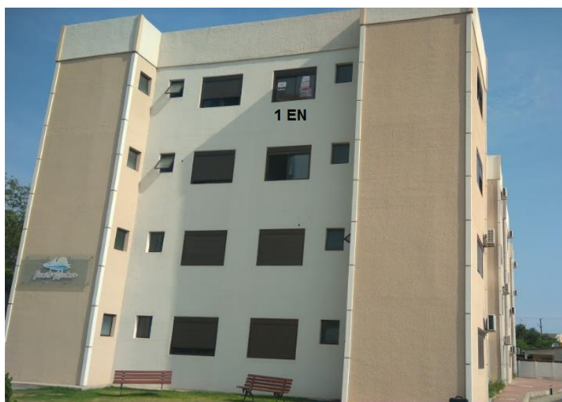
Figura 74- Janela 1EN edifício de paredes de concreto moldadas in loco
