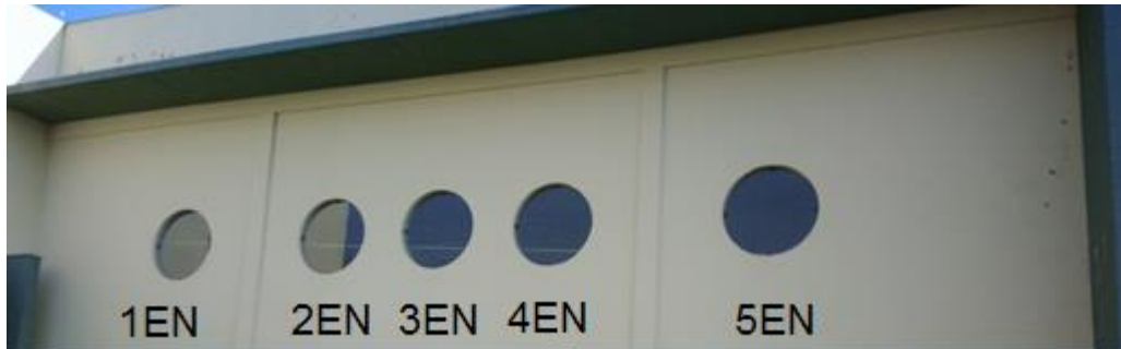
Figura 31-Esquadrias circulares fachada norte
