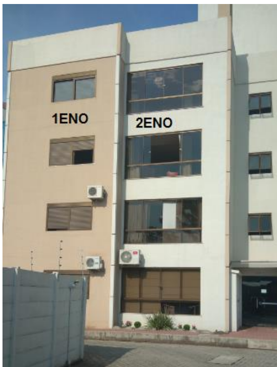
Figura 78- Janela 1ENO edifício de paredes de concreto moldadas in loco
