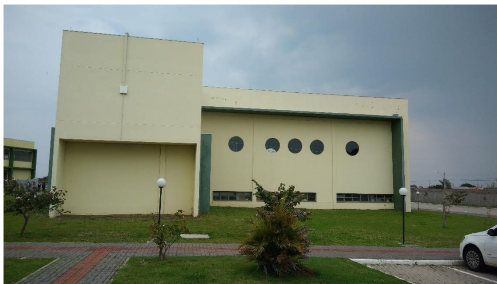
Figura 29-Fachada norte da edificação do NTIC
