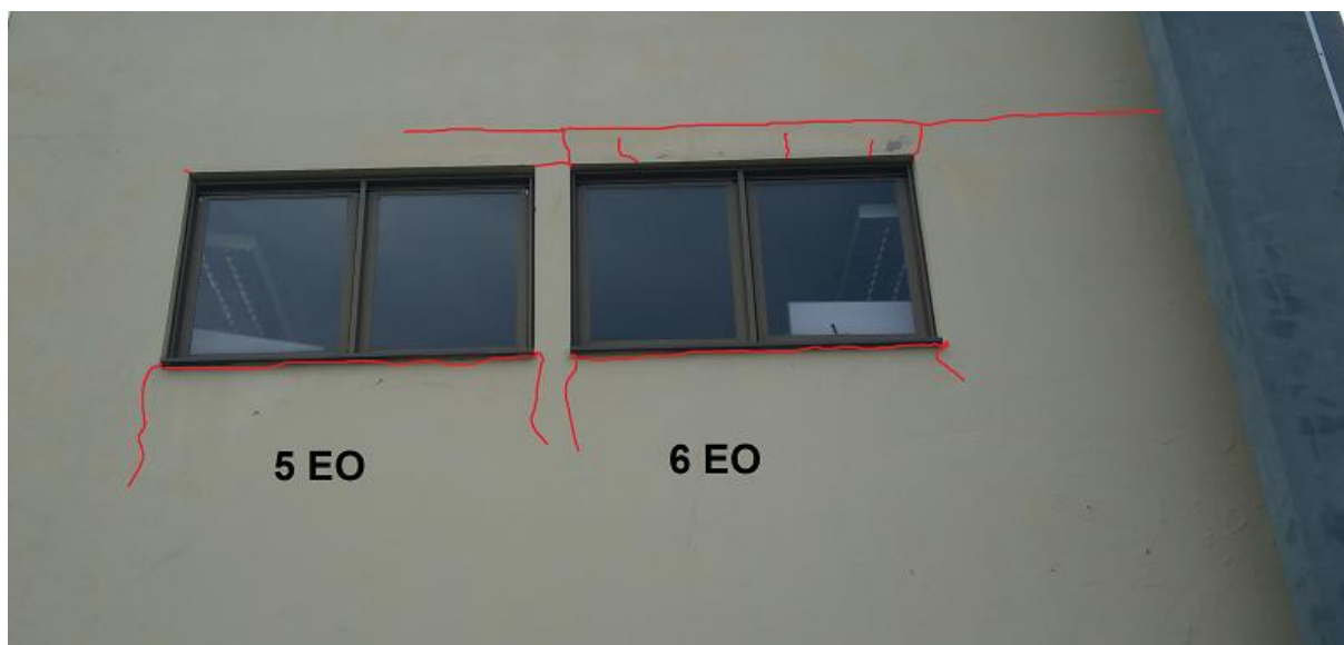
Figura 68-Janelas 5EO e 6EO
