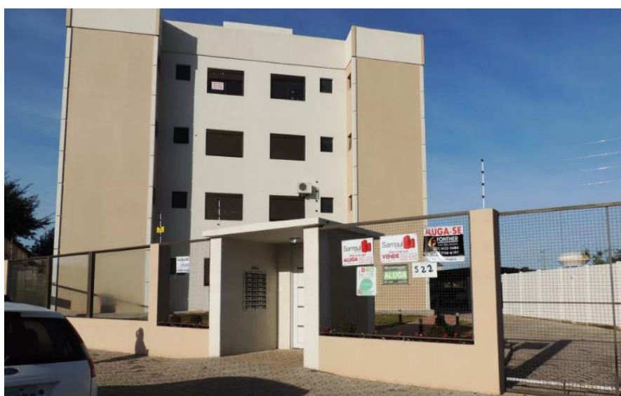
Figura 73-Fachada do edifício de paredes de concreto moldadas in loco
