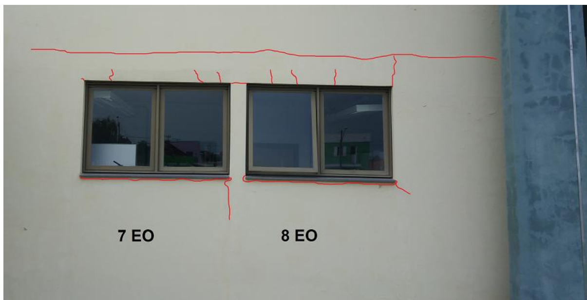
Figura 70-Janelas 7EO e 8EO
