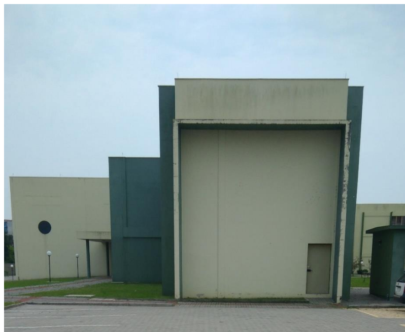
Figura 42-Fachada sul da edificação do NTIC
