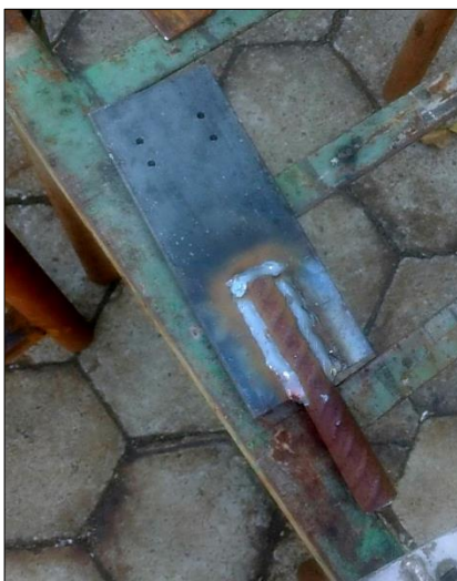
Figura 21 – Adaptação com vergalhão soldado à chapa intermediária
