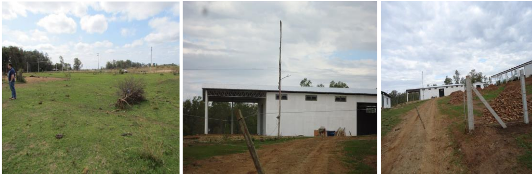
Figura 3 - Área em construção do Parque Alegretense de Resíduos
