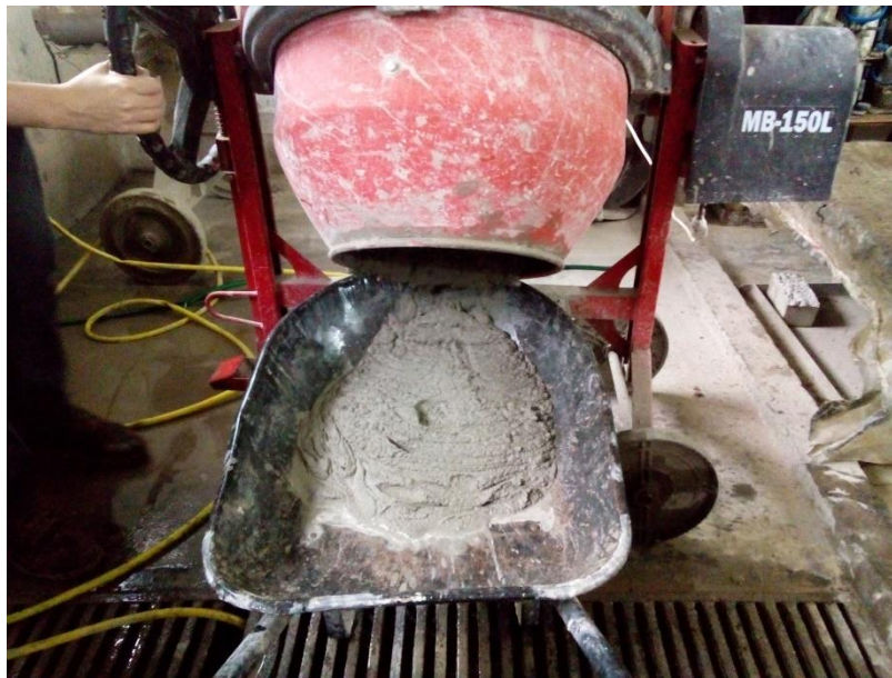
Figura 23 - Execução das argamassas com a utilização de betoneira.
