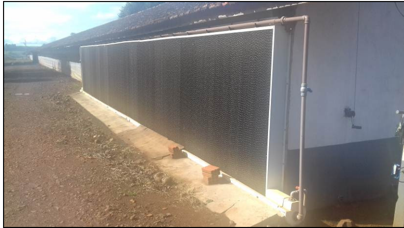
FIGURA 18 - Placa evaporativa. Fonte: Arquivo pessoal.
