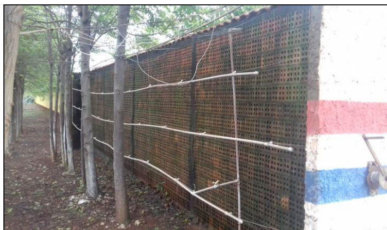
FIGURA 19 - Placa evaporativa alternativa construída com blocos de tijolos. Fonte: Arquivo pessoal.
