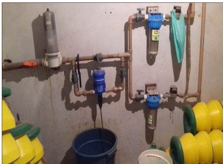
FIGURA 22 - Dosador para administração de medicamentos. Fonte:Arquivo pessoal
