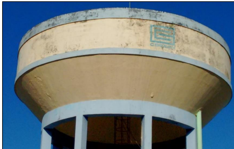
Figura 47 – Vista da face oeste do reservatório R03
