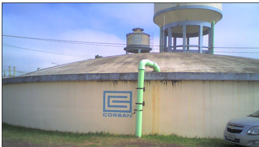
Figura 29 – Face sudeste do reservatório R01
