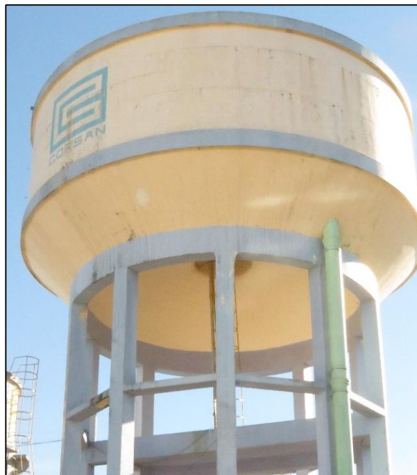
Figura 35 – Vista geral do reservatório R02
