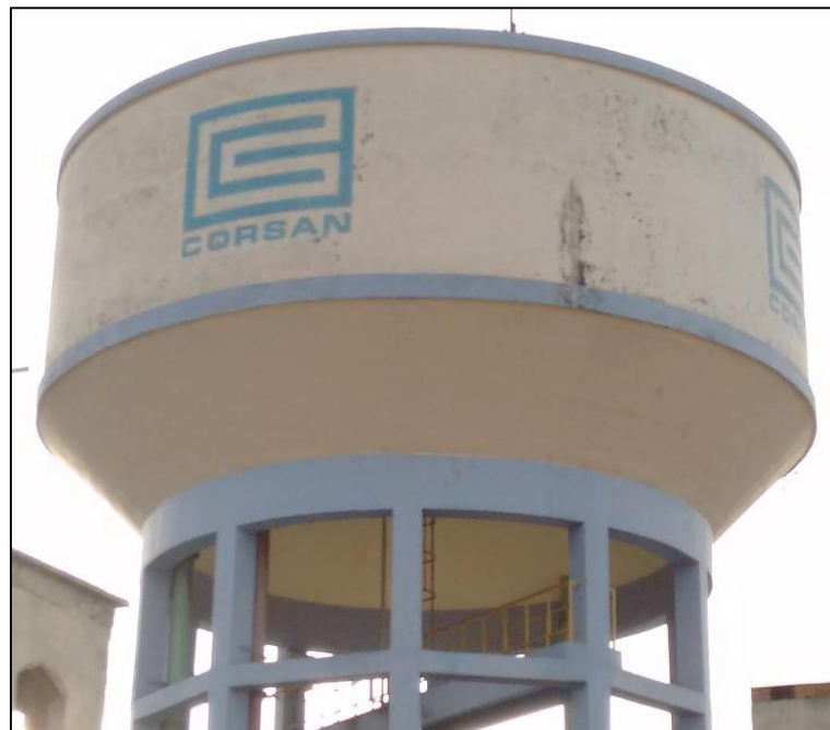
Figura 64 – Vista geral da face sudeste do reservatório R05
