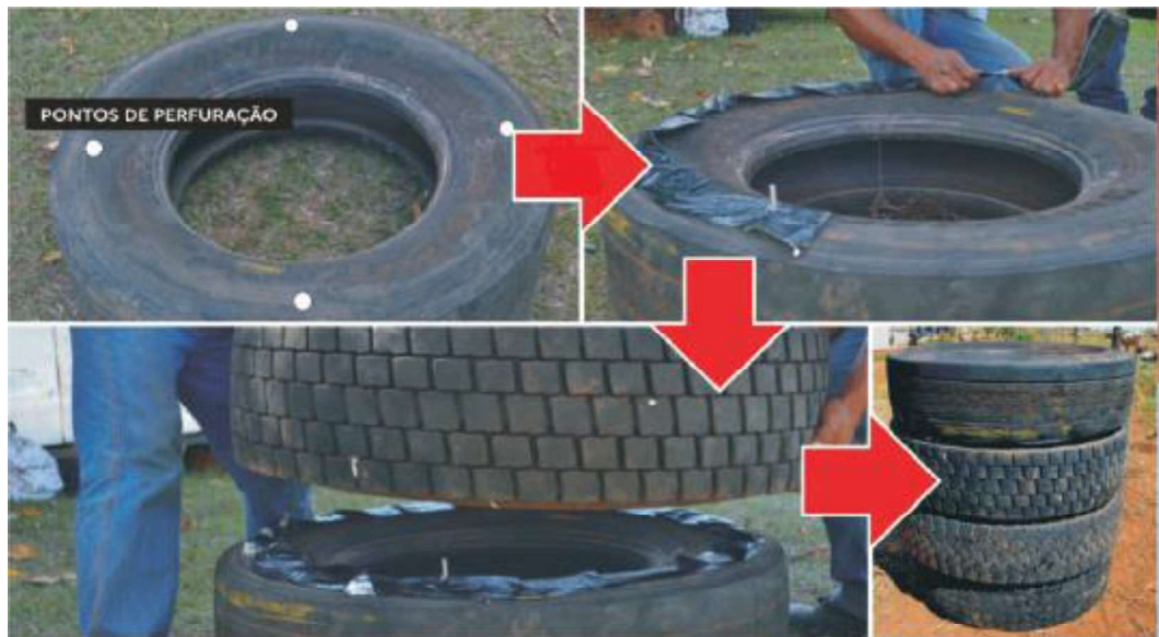
Figura 17 - Pontos de perfuração para acoplamento dos pneus
