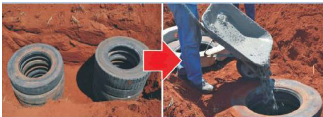
Figura 20 - Colocação e concretagem do piso dos módulos
