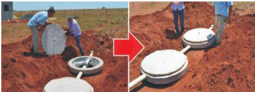
Figura 23 - Colocação das tampas para vedação
