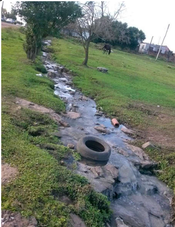
Figura 11 - Esgoto a céu aberto na rua Plínio Brasil Milano
