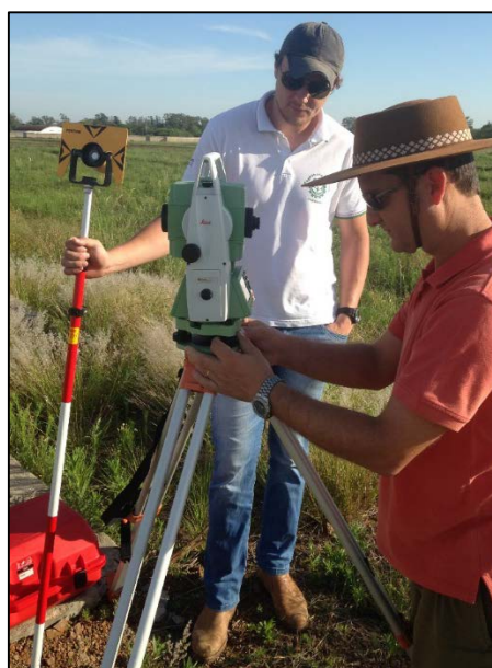
Figura 22 – Instalação e importação dos pontos de controle para a estação total.
