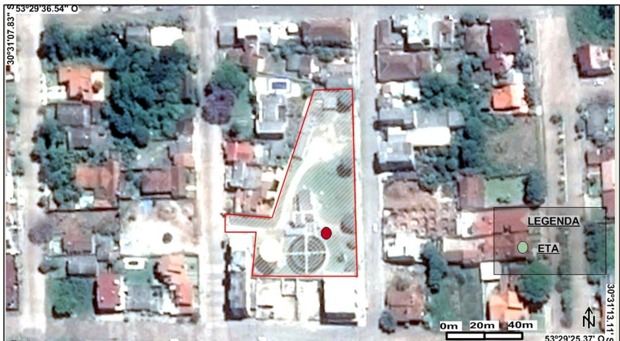
Figura 2- Estação de Tratamento de Água
