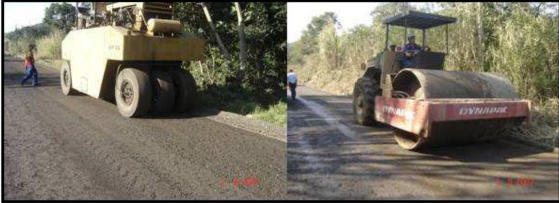
Figura 26- Compactação final da camada reciclada
