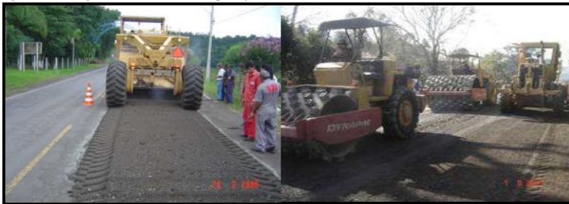
Figura 25- Passagem da recicladora e compactação inicial da camada reciclada
