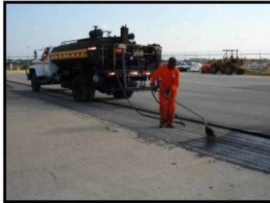
Figura 8 - Etapa de imprimação/pintura de ligação.
