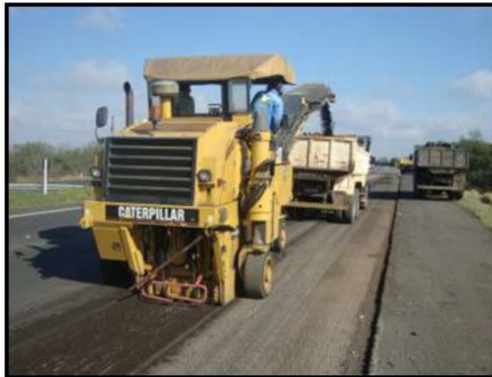
Figura 11 - Processo de fresagem à frio
