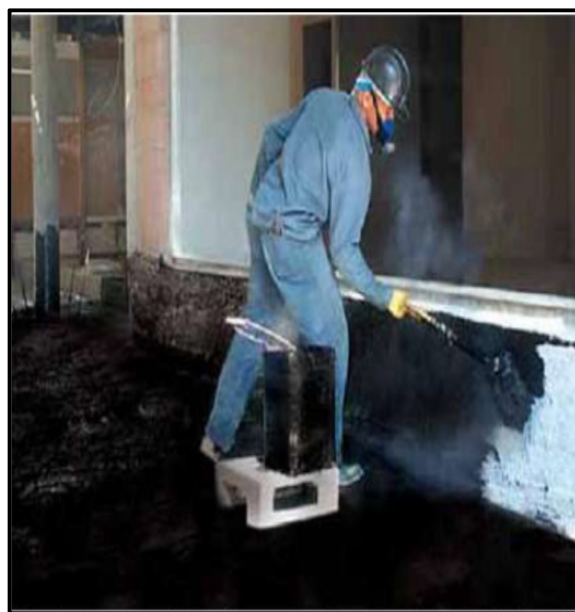
Figura 11b - Membrana asfáltica a quente
