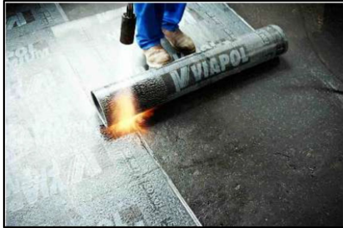
Figura 12 – Manta asfáltica sendo aplicada
