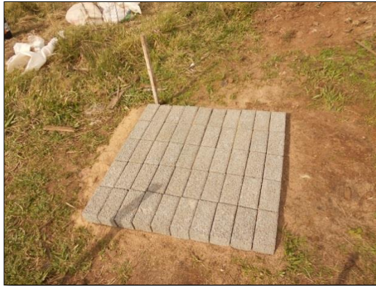
Figura 15 - Assentamento dos blocos de concreto permeável
