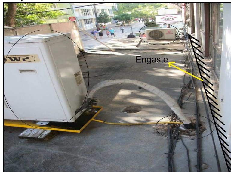
Figura 27 – Perfuração na laje da marquise M2
