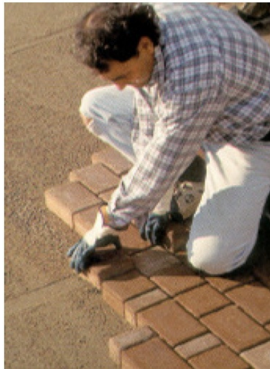
Figura 3: Assentamento manual dos blocos
